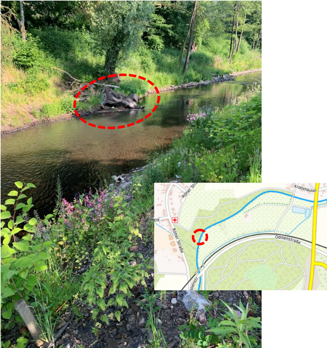
Abbildung 9 - Inde zwischen Brücke Odilienstraße und Brücke Stoltenhoffstraße - Blickrichtung flussabwärts
