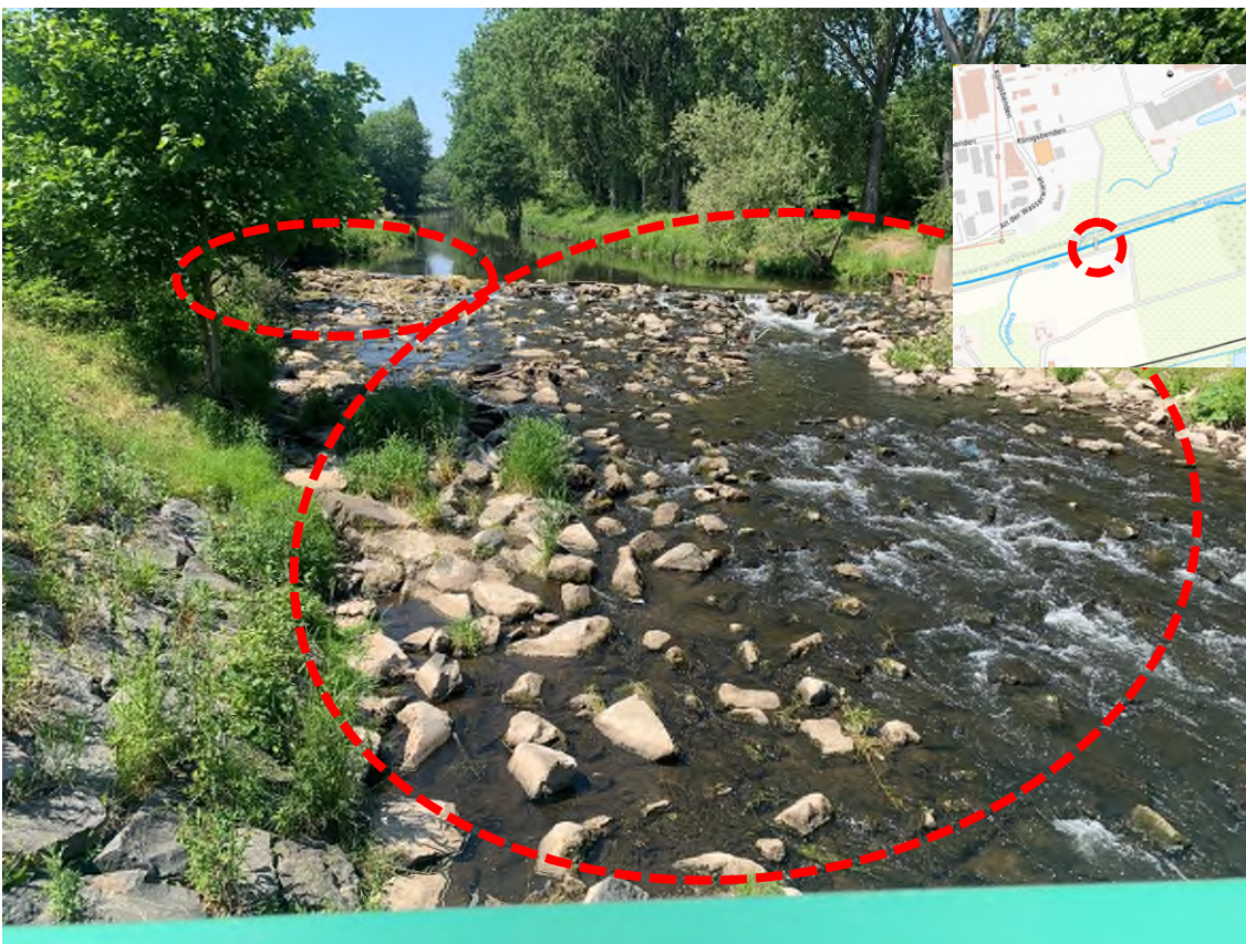
Abbildung 31 - Inde - Blick flussaufwärts von der Brücke Lynenwehr
