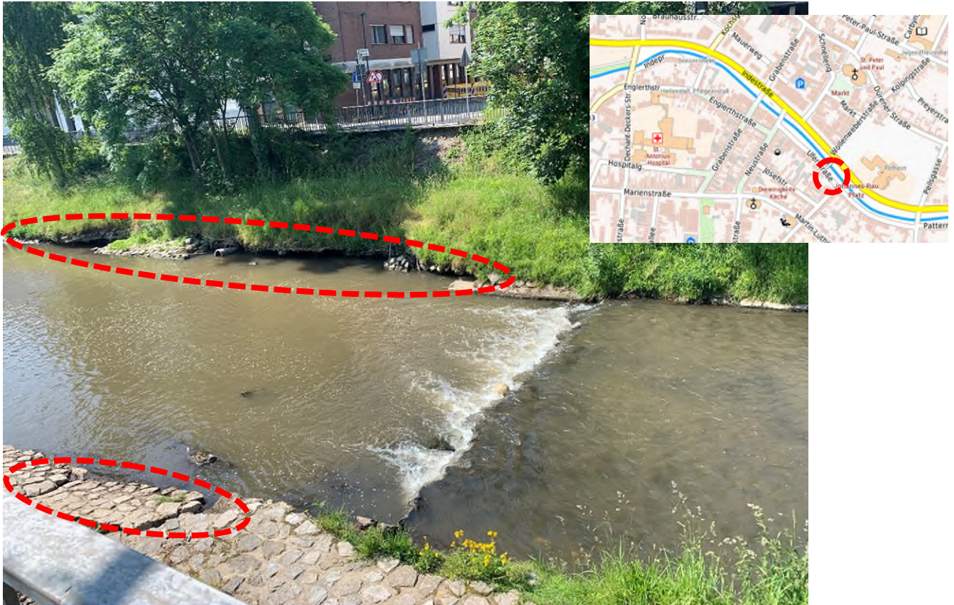
Abbildung 19 - Inde - Innenstadt Eschweiler - hinter Brückenbauwerk Neustraße - Blick flussabwärts
