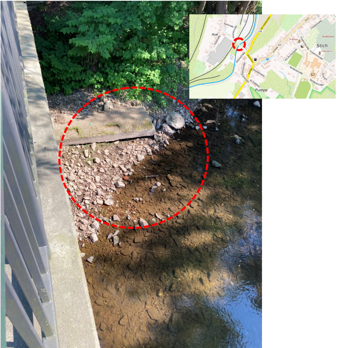
Abbildung 5 - Inde - Blick von Brücke Phönixstraße flussaufwärts
