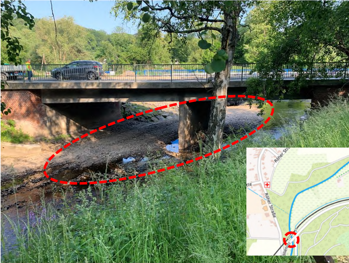
Abbildung 8 - Inde - Brücke Odilienstraße - Blickrichtung aus Im Hasselt flussabwärts
