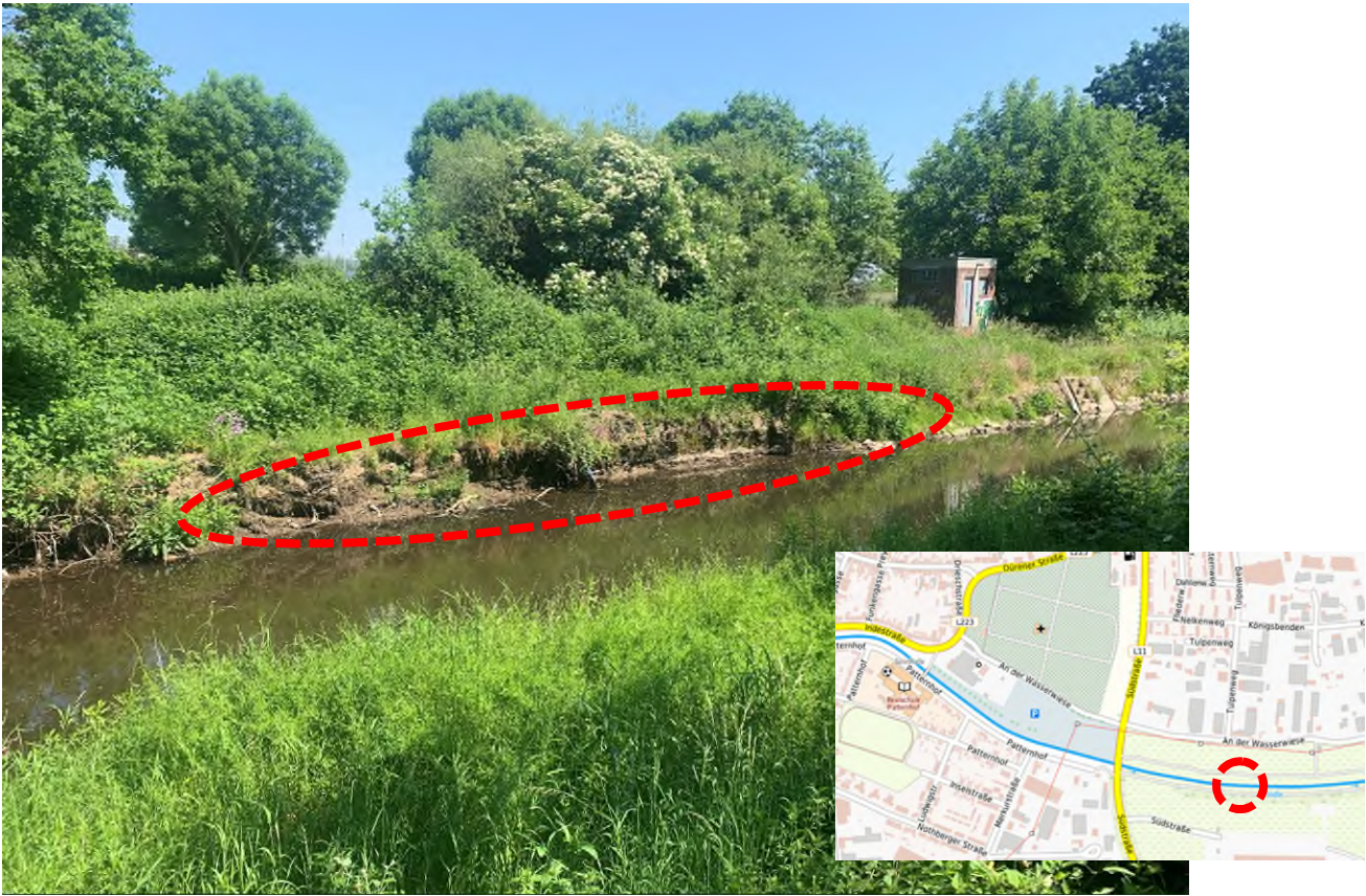
Abbildung 29 - Inde - im Bereich der Pegelmessstation
