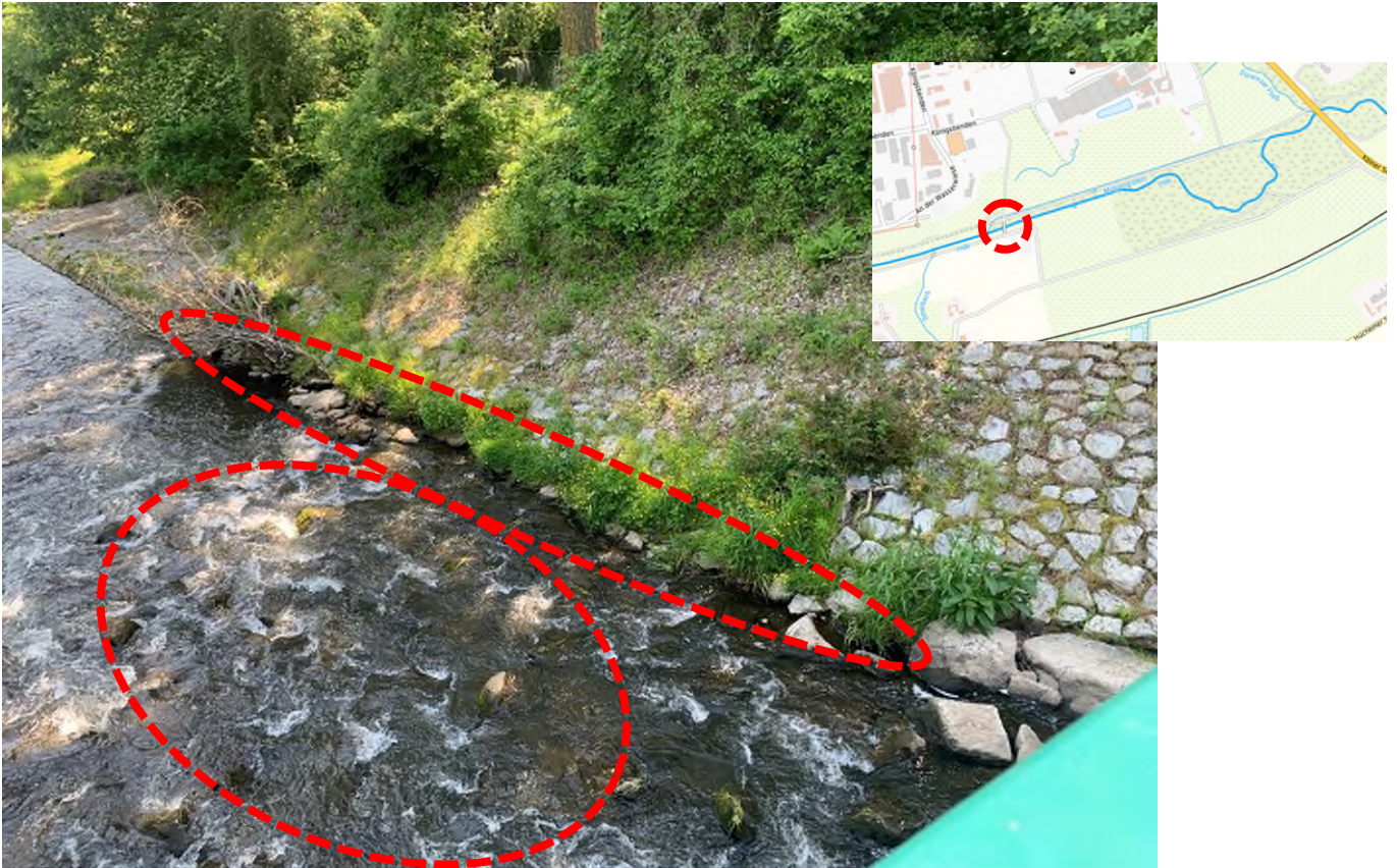
Abbildung 32 - Inde - Blick flussabwärts von der Brücke Lynenwehr
