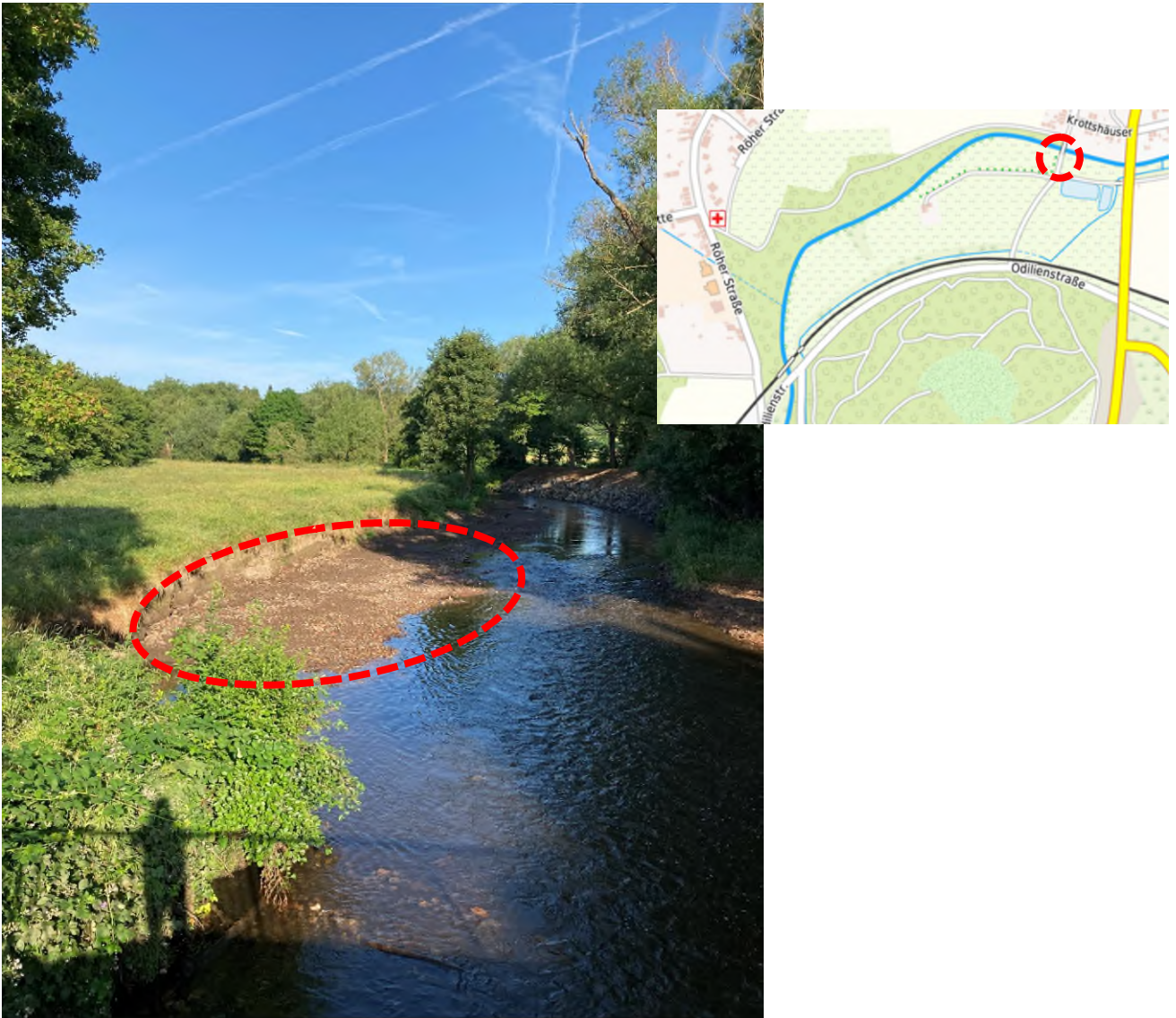
Abbildung 10 - Inde - Blick von der Brücke Stoltenhoffstraße flussaufwärts
