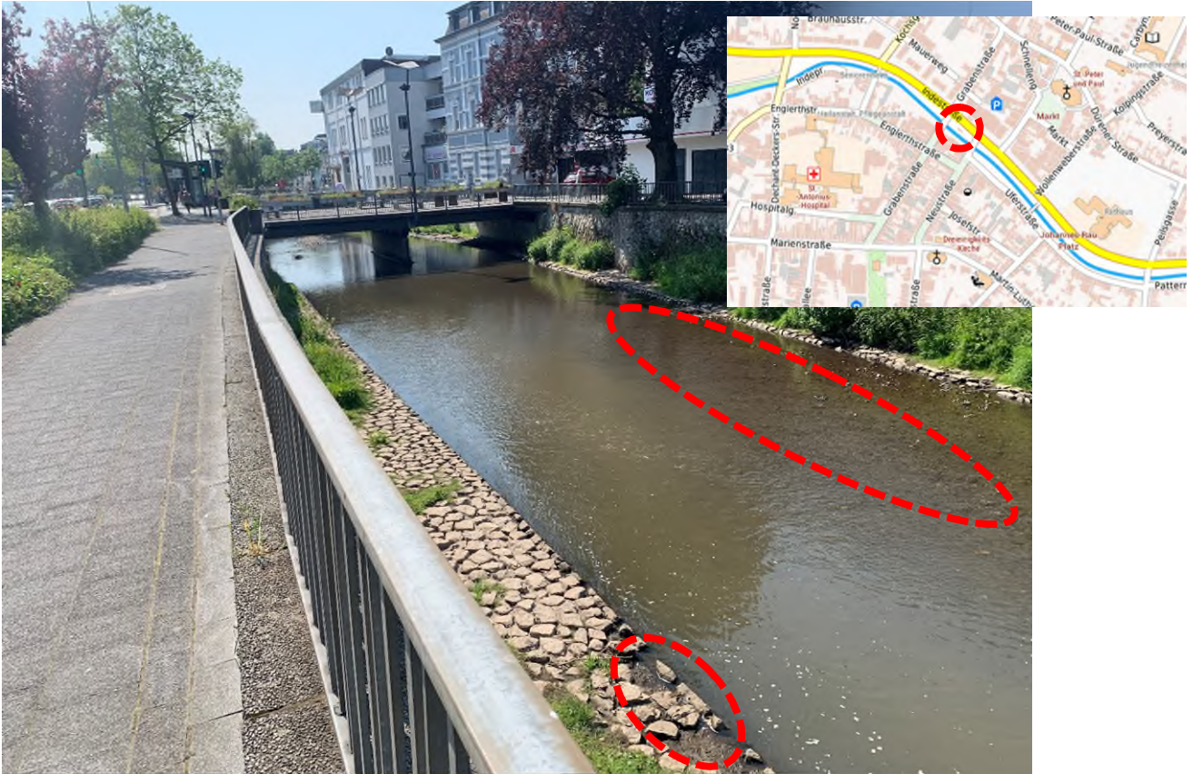
Abbildung 16 - Inde - Innenstadt Eschweiler - Blick flussabwärts zwischen Brücke Grabenstraße und Brücke Neustraße
