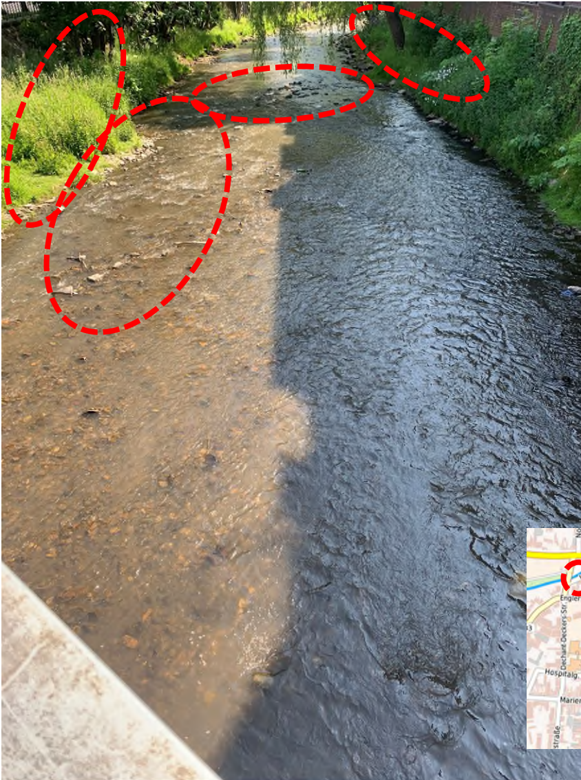
Abbildung 13 - Inde - Innenstadt Eschweiler - Blick von Brücke Langwahn flussabwärts
