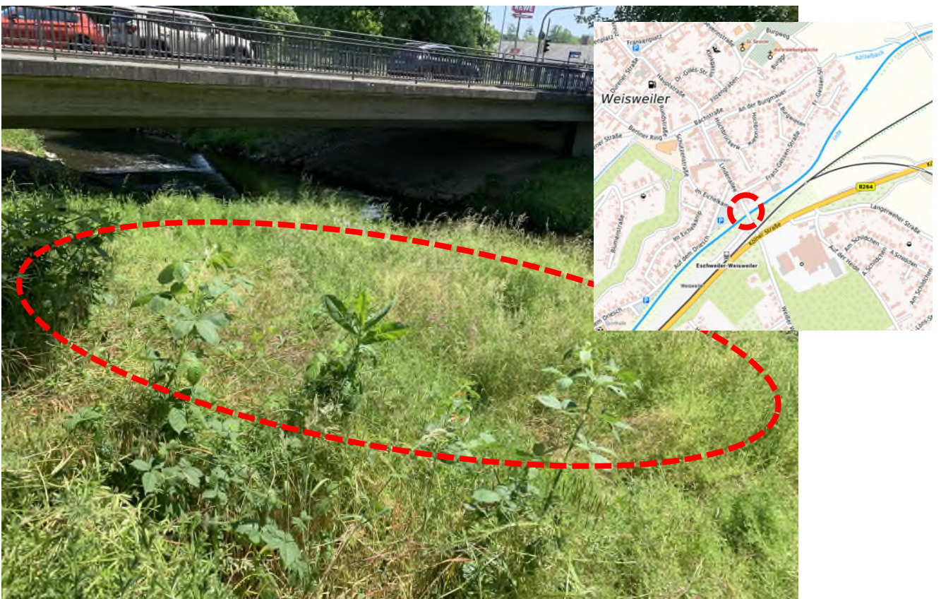
Abbildung 34 - Inde - Brücke Lindenallee
