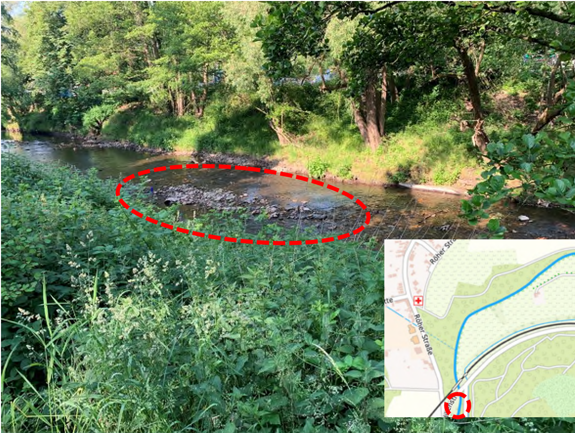
Abbildung 7 - Inde im Bereich der Brücke Odilienstraße - Blickrichtung flussabwärts
