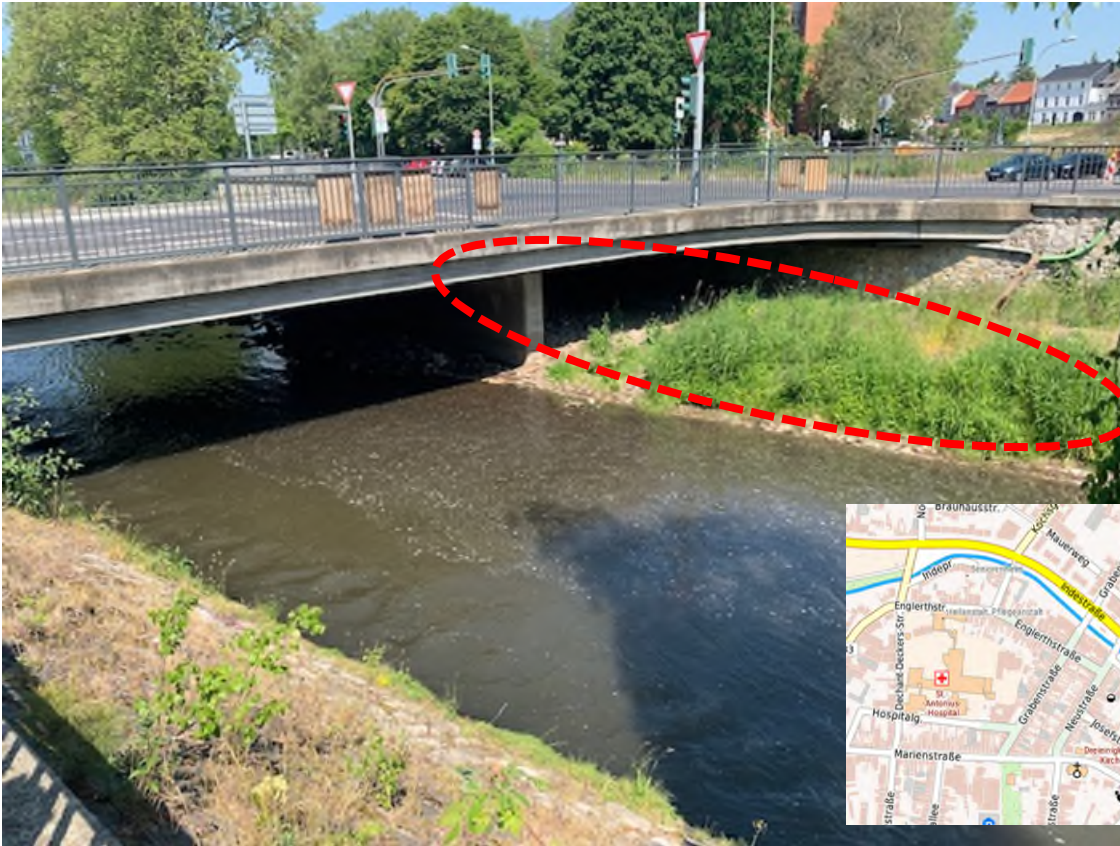
Abbildung 22 - Inde - Brücke Bergrather Straße - Blick flussaufwärts
